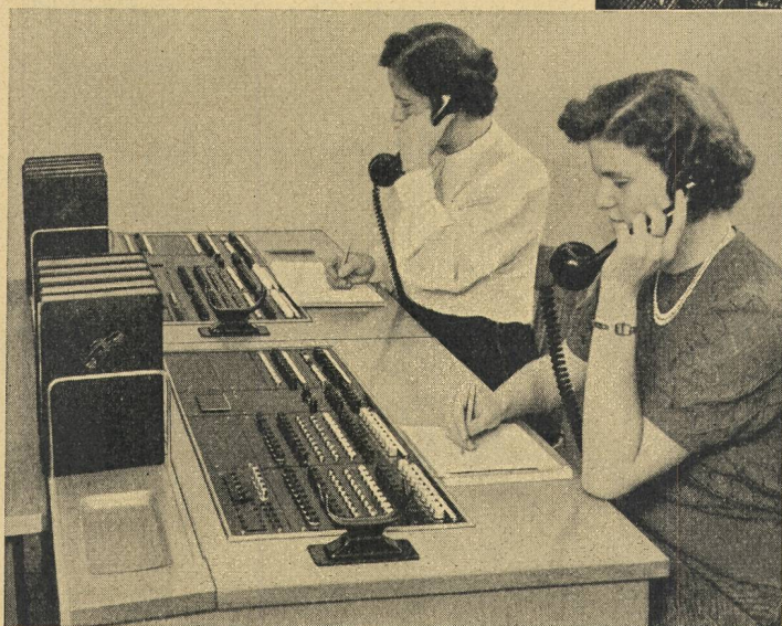
Neue schnurlose Vermittlungseinrichtung mit Zahlengabe für Telephonanlagen mit 20 Amtsleitungen.
