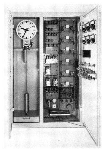
Fig. 5. Innerer Aufbau der Zeitzentrale
