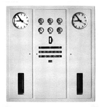
Fig. 4. Zeitzentrale eines Fernknotenamtes mit sechs Nebenuhrlinien, in Stahlschrank putzbündig eingebaut Central horaire d'un central nodal interurbain à six lignes d'horloges secondaires, monté à fleur de la paroi dans une armoire d'acier
