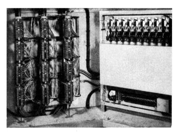
Fig. 3. Verteiler- und Relaiskasten Armoires de distribution et des relais
