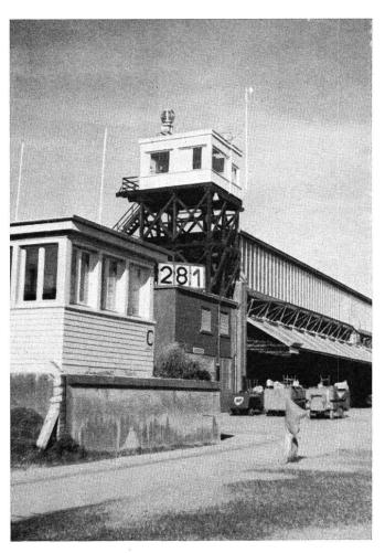
Fig. 4. Der provisorische Kontrollturm, Sitz der Nahzonenkontrolle. Auf dem Dach der Drehscheinwerfer. Die Zahlen unterhalb des Turmes bezeichnen die zur Zeit zu benützende Piste
