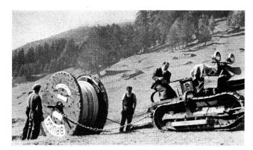
Fig. 2. Transport de câble au moyen d'un tracteur à chenilles
