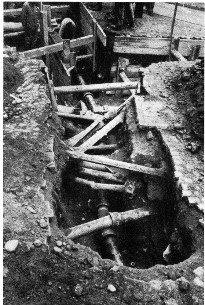
Fig. 6. Enchevêtrement de conduites industrielles
