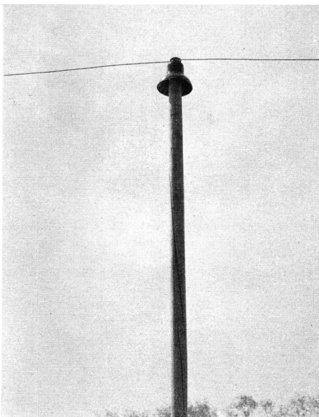
Fig. 1. Poteau télégraphique avec isolateur de verre, utilisé à l'époque de l'introduction du télégraphe en Suisse, en 1852
