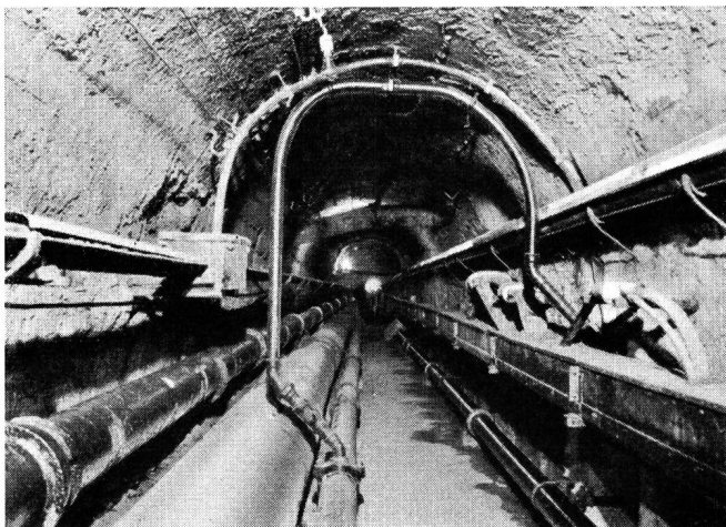
Fig. 7. Conduites industrielles posées dans une galerie
