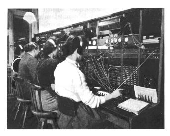
Fig. 3. ZB-Zentrale Amriswil vor der Umschaltung auf den automatischen Betrieb
