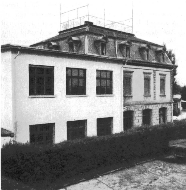
Fig. 4. Postgebäude Amriswil mit dem An- bzw. Aufbau für die neue automatische Zentrale
