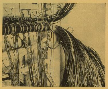
SOFLEX-DRAHTBÜNDEL IN UNGESCHALTETEM RELAISGESTELL
