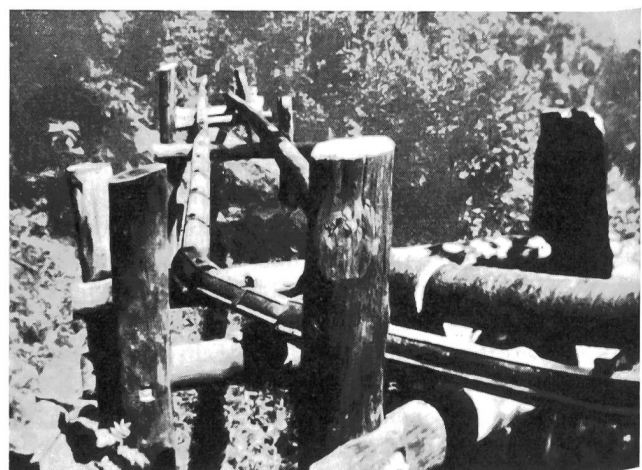
Fig. 8. Kabelführung durch ein Rutschgebiet
