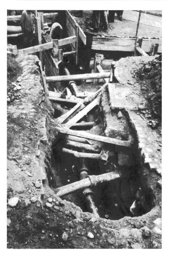
Fig. 9. Labyrinth unter der Strasse, freigelegte Werkleitungen
