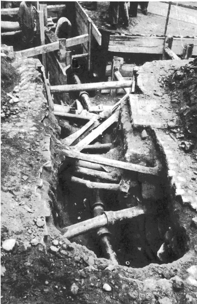
Fig. 9. Labyrinth unter der Strasse, freigelegte Werkleitungen
