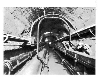
Fig. 10. Werkleitungen in einem Stollen
