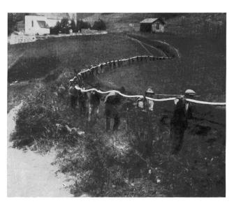
Fig. 6. Das Austragen eines Kabels
