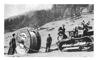
Fig. 5. Kabeltransport mit einem Raupentraktor
