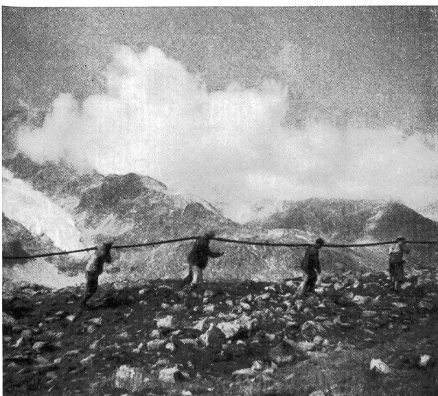
Fig. 5. Kabelauszug über eine Geröllhalde
