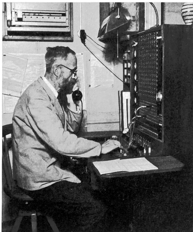
Fig. 7. Die bis zur Automatisierung in Betrieb gestandene handbediente Zentrale Poschiavo
