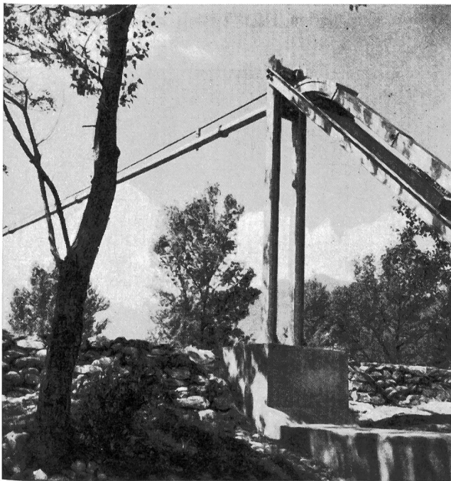
Fig. 3. Sostegno B, veduta generale Stützpunkt B, Gesamtansicht
