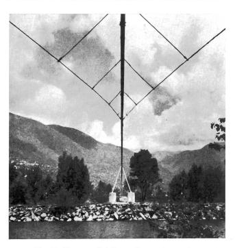
Fig. 11. Trasversali delle cordine contravvento Querstäbe der Windabspannseile
