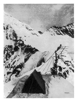
Fig. 6. Installation d'essais de transmission par ondes dirigées de 2 m sur l'arête nord-est de la Jungfrau (3660 m). Les appareils de mesure sont installés dans la tente. Audessous de l'observatoire du Sphinx, on voit dans les rochers, de gauche à droite, le nouvel hôtel, l'ancien hôtel et la station de recherches de haute montagne.
