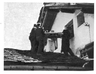
Fig. 6. Die je etwa 300 Kilogramm wiegenden Automatengestelle werden über ein Steinplattendach und durch das kleine Zentralenfenster an ihren Standort gebracht
