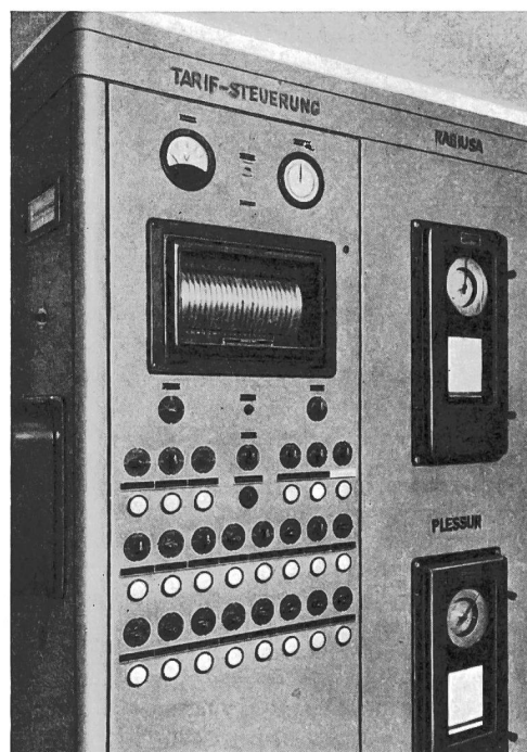
Fig. 4. Kommandogerät der Zentralsteuerungsanlage der Licht- und Wasserwerke der Stadt Chur in der Zentrale Sand
