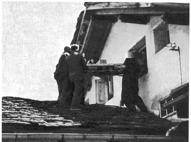
Fig. 6. Die je etwa 300 Kilogramm wiegenden Automatengestelle werden über ein Steinplattendach und durch das kleine Zentralenfenster an ihren Standort gebracht
