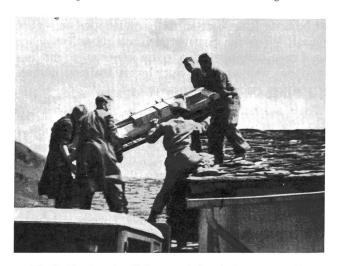
Fig. 5. Erschwerter Zutransport der Automatengestelle
