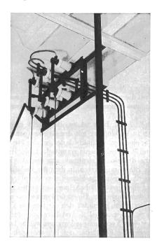
Fig. 3. Einführung in eine Transformatorenstation  $3\times10~000$  Volt durch Hochspannungskabel mit Sucothen-Isolation
