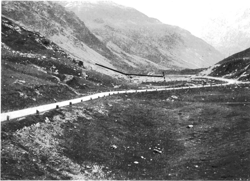
Fig. 11. Meßstrecke 7 — Tronçon 7 Alp Julier
