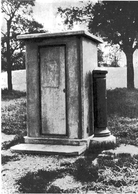
Fig. 3a. Betonhäuschen für Leitungsdurchschalter mit Verteilkasten
