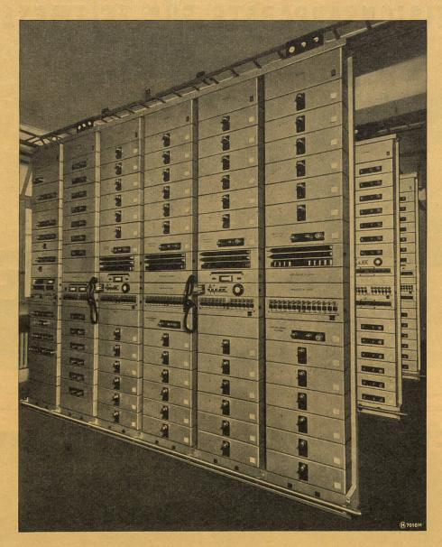
Ansicht einer Endausrüstung mit 2 Buchten für die Trägerversorgung von 12 24-Kanalsystemen und mit 4 Buchten für 2 24-Kanalsysteme. Im Hintergrund Linienverstärker.
