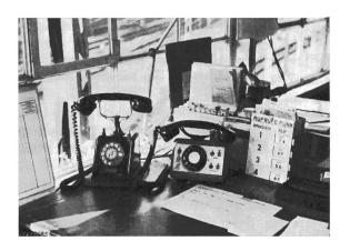
Fig. 5. Sprechstelle der Rangierfunkanlage auf dem Tisch des Aufsichtsbeamten im Hauptstellwerk. Sprechstelle mit Betriebsanzeigelämpehen, Nummernscheibe und Fernschalter mit Kontrollampen für Sendevorheizung und Empfänger
