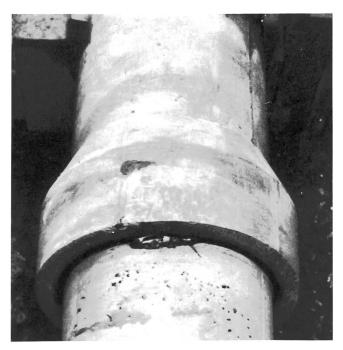
Fig. 6. Fertig ausgegossene Betonrohrmuffe Coulage terminé
