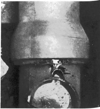
Fig. 5. Eingiessen des Muffenkittes Coulage du mastic
