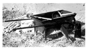
Fig. 2. Heizbare Karrette, in welcher der Muffenkitt dünnflüssig gemacht wird Brouette chauffante servant à rendre le mastic fluide
