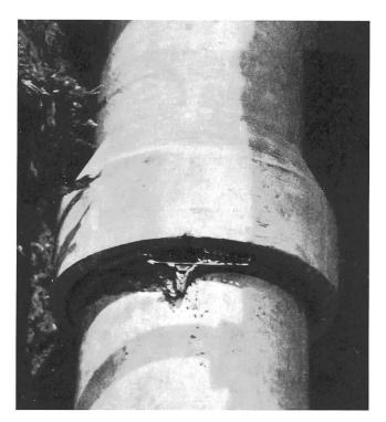
Fig. 4. Betonrohrmuffe mit umgelegtem Gummiring, zum Ausgiessen bereit
