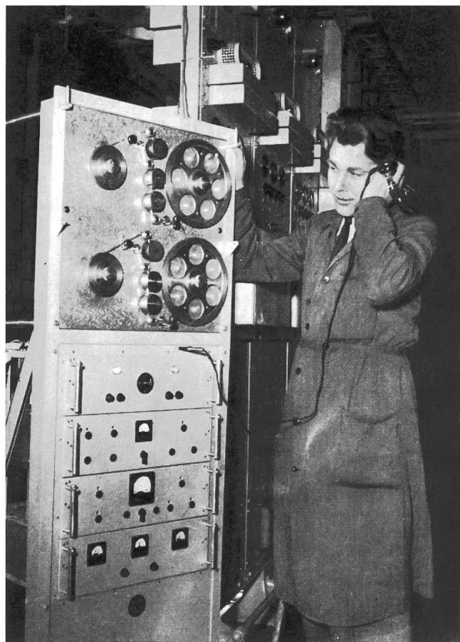
Fig. 3. Sprechmaschine mit zwei getrennten Bändern (Prototyp)
