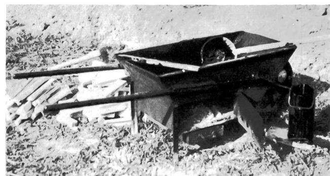
Fig. 2. Heizbare Karrette, in welcher der Muffenkitt dünflüssig gemacht wird
