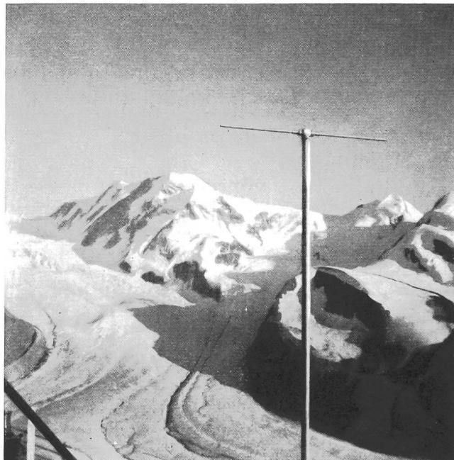
Fig. 1. Drahtlose Telephonanlage Gornergrat—Monte - Rosa-Hütte. Antenne der Amtsstation
