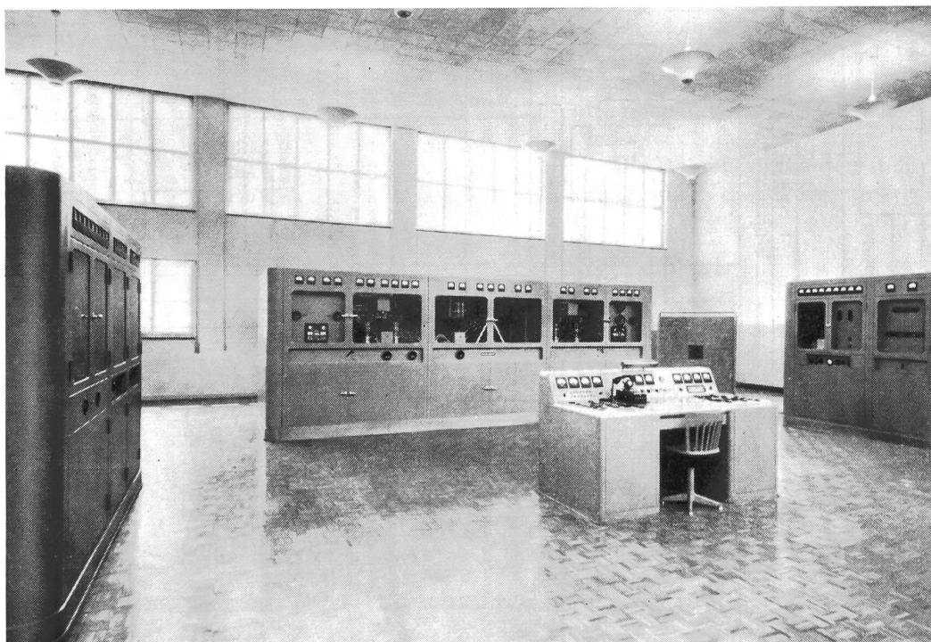
Fig. 5. Der neue Sendesaal mit dem Brown-Boveri-Sender, regulierbar von 100...200 kW HF-Leistung
