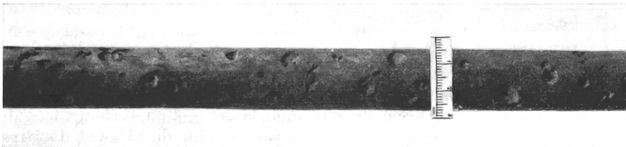
Fig. 18. Elektrolytische Korrosion, vermutlich durch kleine Ströme Corrosion électrolytique due probablement à de faibles courants
