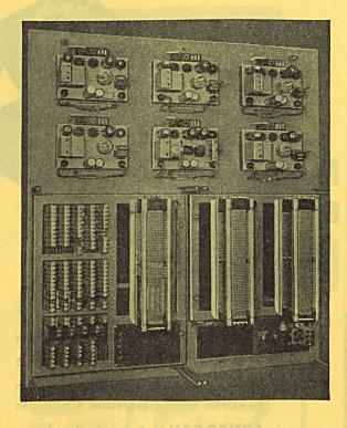
Automatische Wähleinrichtungen zu Gegensprechanlagen, gebaut nach dem System des Kreuzwählers
