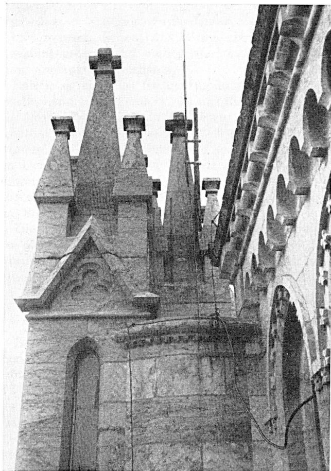
Fig. 3. Befestigung des vertikalen Sendedipols
