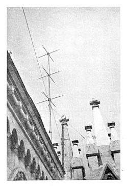
Fig. 10. Horizontal polarisierte Turnstile-Antenne auf der Kathedrale St-Pierre
