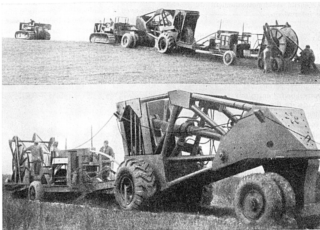
Fig. 48. Bêche-poseuse utilisée pour enterrer les câbles téléphoniques
