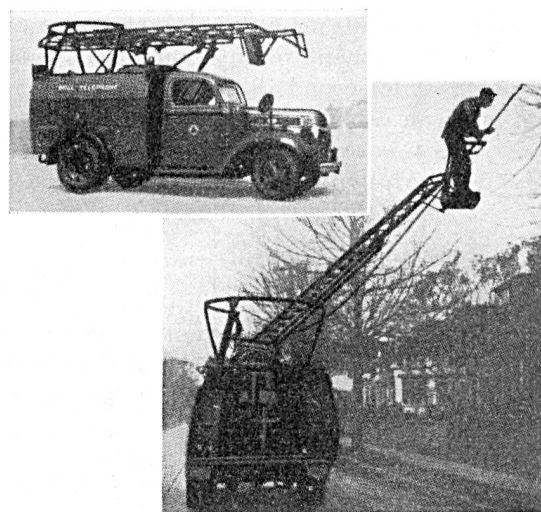
Fig. 38a. Camionnette avec échelle extensible pour le service de réparation et d'entretien des lignes aériennes
