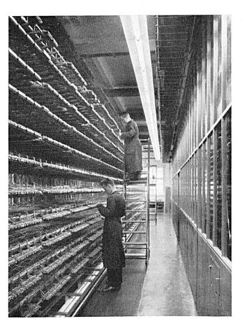
Fig. 14. Horizontal- oder Stripsseite des in Abbildung 13 wiedergegebenen Hauptverteilers
