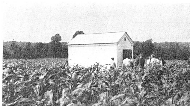
Fig. 19. Station amplificatrice non surveillée pour amplificateurs à large bande des câbles coaxiaux New-York—Washington
