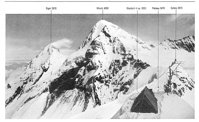
Uebertragungsversuche mit 2-m-Wellen, Standort 4 am Nordostgrat der Jungfrau, 3650 m ü. M. Die Speisung der Geräte erfolgte über ein Gummikabel, das vom Plateau dem Grat entlang verlegt war. Links, unter der Winkelreflektor-Antenne, der elektrische Scheinwerfer. Das Gotthardzelt hat sich auch in dieser luftigen Höhe bewährt. Senkrecht unter dem Sphinx-Observatorium, von links nach rechts im Felsen sichtbar: Berghaus, altes Touristenhaus und Hochalpine Forschungsstation
