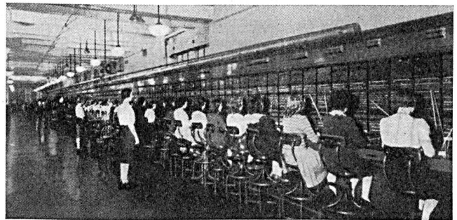
Fig. 8. Vue générale d'un central téléphonique
