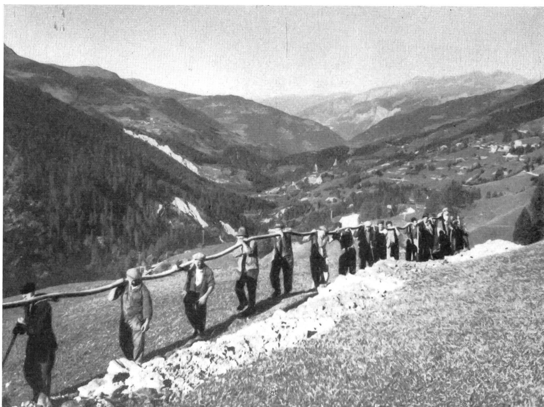
Fig. 2. Kabelzug Chur—Arosa, zwischen Peist und Langwies
