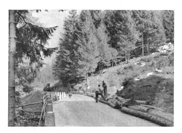
Fig. 2. Sicherung des Kabels durch ein Rundholzpolster Protection du câble au moyen de rondins.
