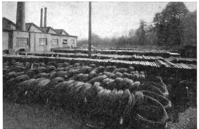
Fig. 2. Lager von Kupferbarren und -draht auf dem Areal der S.A. des Câbleries et Tréfileries in Cossonay Dépôt de lingots et de fil de cuivre sur les chantiers de la S.A. des Câbleries et Tréfileries de Cossonay
