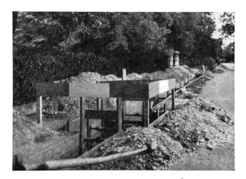
Fig. 5. Grabenspriessung und -absperrung Etayage et barrage de fouilles
