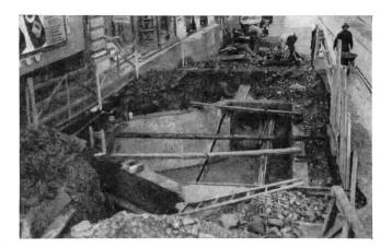
Fig. 4. Grosser Dreieckschacht vor einer Zentrale. Einmündung von 500 mm und 300 mm Ø Betonröhren Grande chambre triangulaire devant un central. Aboutissement de tuyaux en béton de 500 et 300 mm Ø
