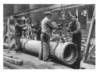
Fig. 2. Verlegen eines 500 mm  $\varnothing$  armierten Schleuderbetonrohres Pose d'un tuyau en béton armé centrifugé de 500 mm  $\varnothing$
