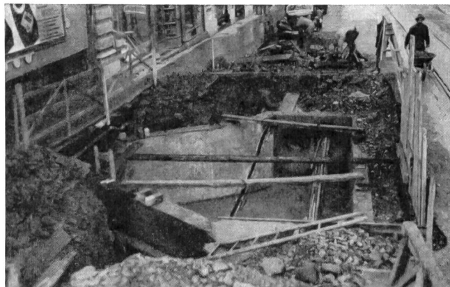
Fig. 4. Grosser Dreieckschacht vor einer Zentrale. Einmündung von 500 mm und 300 mm \varnothing Betonröhren Grande chambre triangulaire devant un central. Aboutissement de tuyaux en béton de 500 et 300 mm \varnothing
