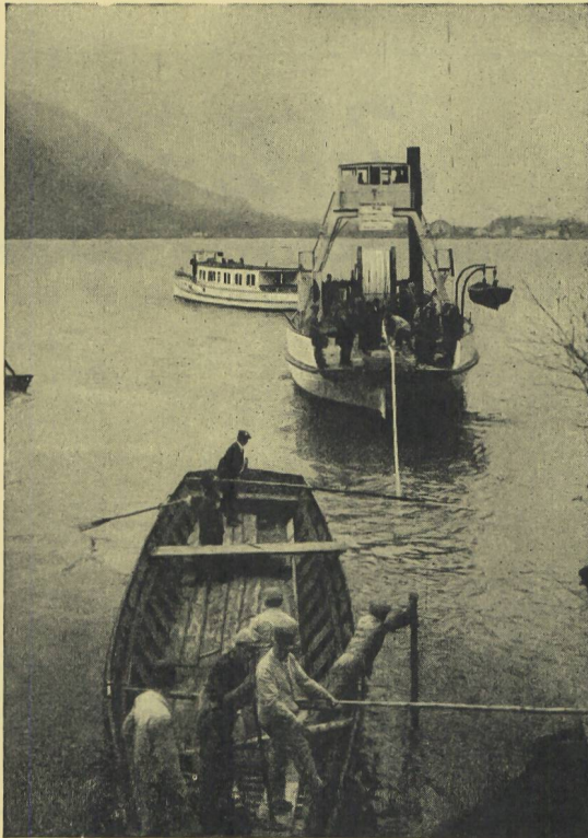
Verlegung eines Telephonkabels im Vierwaldstättersee zwischen Treib u. Brunnen für die Schweizerische Telephonverwaltung. Nov. 1935. Beginn der Kabelversenkung bei Treib.
