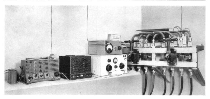
Fig. 1. Installation expérimentale de diffusion par le secteur (Airolo). De gauche à droite: translateur BF, amplificateur BF, dispositif d'alimentation avec connexion au secteur, émetteur d'ondes longues (5 W, 150 à 300 kc/s), circuit d'accord (sur l'émetteur), raccordement au réseau de distribution à basse tension (secteur)
