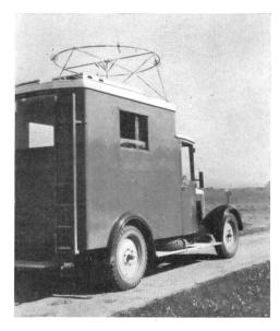
Fig. 8. Feldstärke-Messwagen mit Rundempfangsantenne für horizontal polarisierte Wellen. f $=50~\rm MHz$
