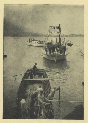
Verlegung eines Telephonkabels im Vierwaldstättersee zwischen Treib u. Brunnen für die Schwelzerische Telephonverwaltung. Nov. 1935. Beginn der Kabelversenkung bei Treib.
