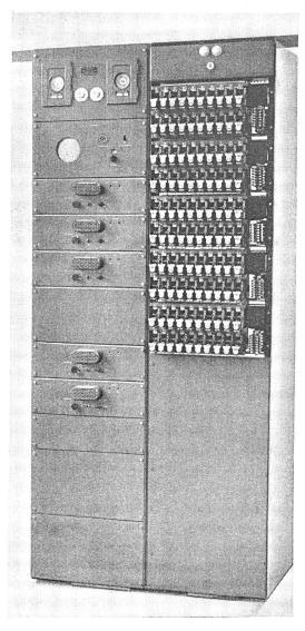
Fig. 4. Verstärker- und Programmwählergestell
