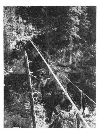
Fig. 8. Höll/Susten. Spannweite 40 m — Portée 40 m
