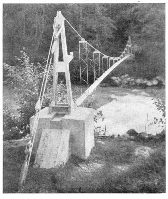
Fig. 4. Nessenthal/Susten. Spannweite 25 m. Auflagesockel Portée 25 m. Fondation
