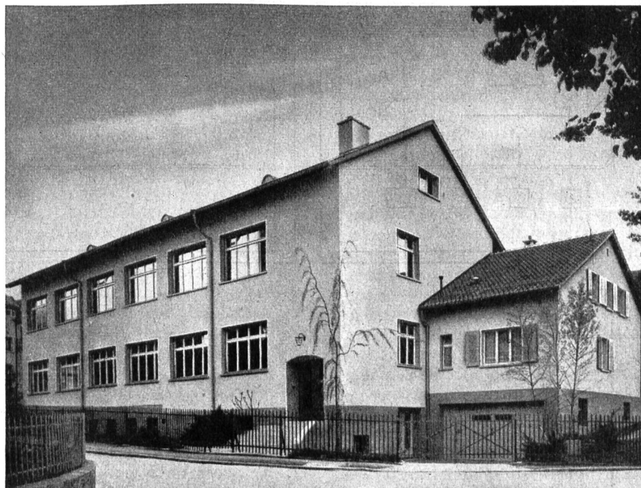
Fig. 4. Ansicht des Gebäudes der Zentrale Bern-Süd. — Bâtiment du central Berne-Sud.
