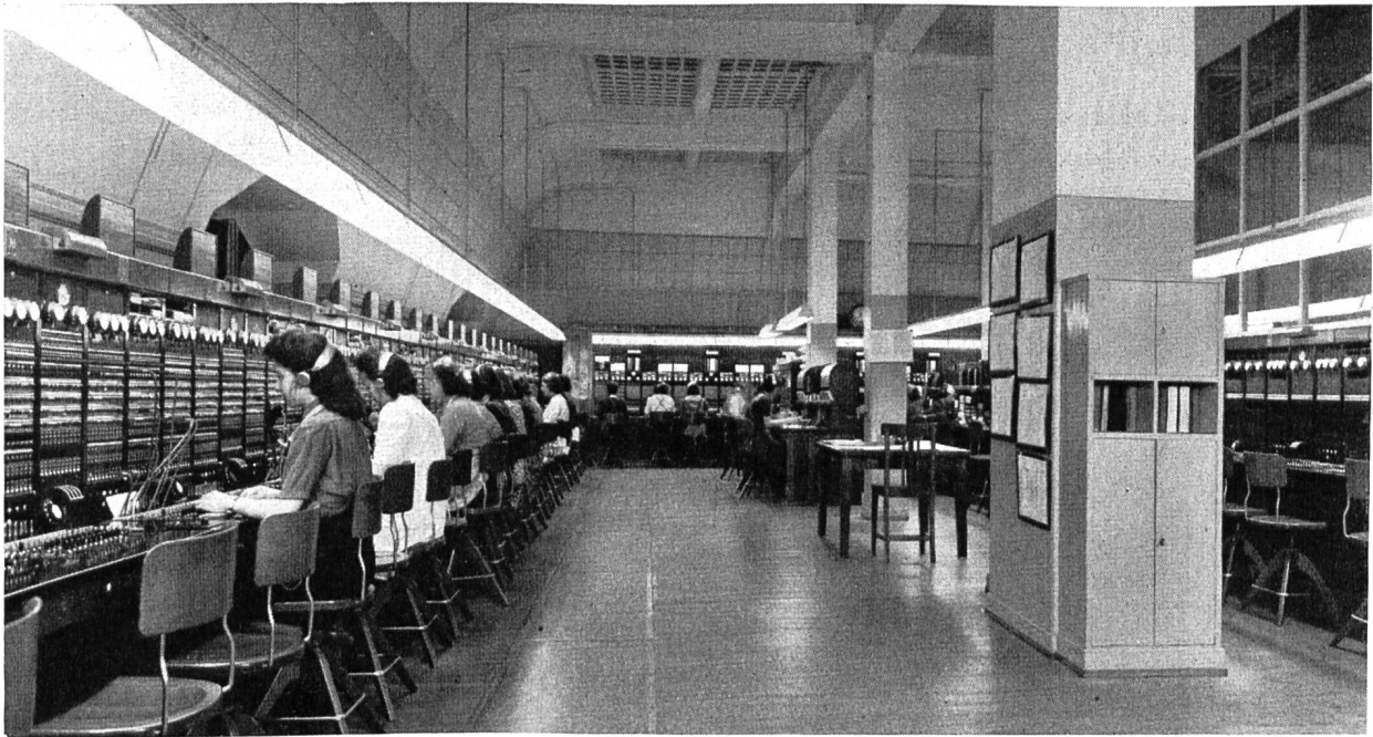
Fig. 1. Telephonzentrale. \frac{2}{3} Leuchtstoffröhren zu 100 Dlm je Arbeitsplatz. Farbe Tageslicht, Diffusoren Belmag, Beleuchtungsstärke 240—280 Lux.
