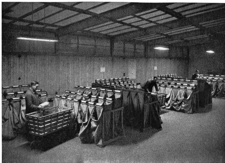
Fig. 3. Paketversand. 2 Leuchtstoffröhren zu 100 Dlm je Sortierstelle. Farbe Tageslicht, Reflektoren Esta, Beleuchtungsstärke 110—170 Lux.
