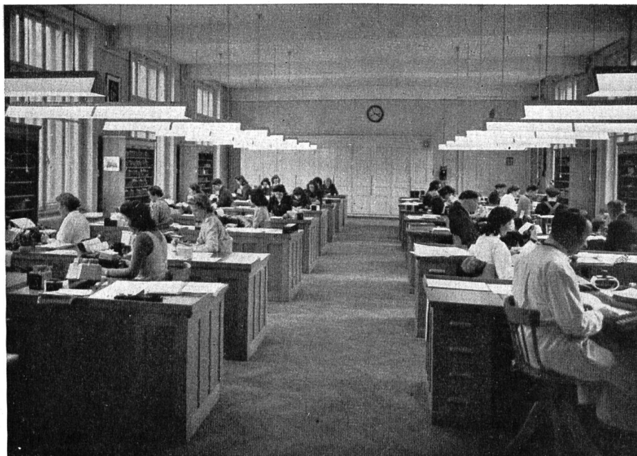
Fig. 2. Checkrevisorat. 1 Leuchtstoffröhre zu 100 Dlm je Arbeitsplatz. Farbe weiss, 3500° K, Diffusoren BAG, Beleuchtungsstärke 180—280 Lux am Arbeitsplatz, Gangmitte 60 Lux.
