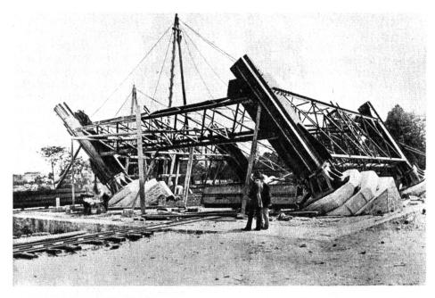
Fig. 2. Commencement du montage métallique.
