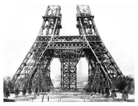
Fig. 3. Montage des piliers au-dessus du premier étage.
