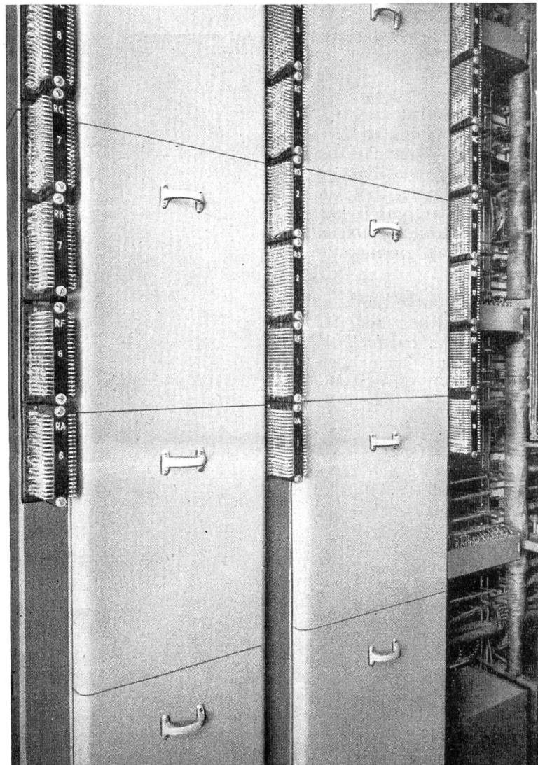
Fig. 11. Feuerschutzdeckel einer automatischen Zentrale Hasler.
