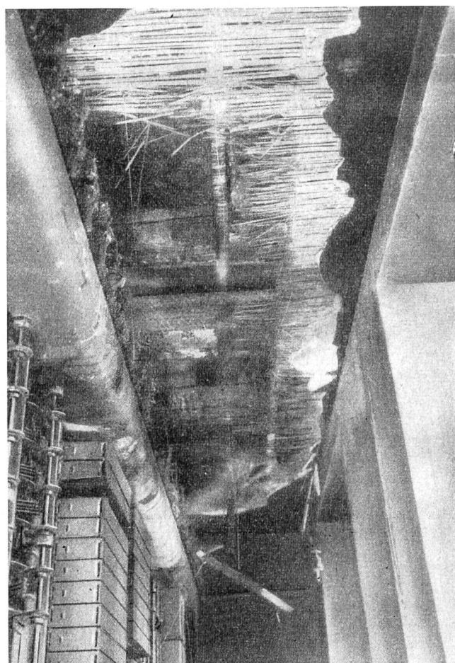
Fig. 8. Ansicht der Decke unmittelbar über dem Brandherd.
