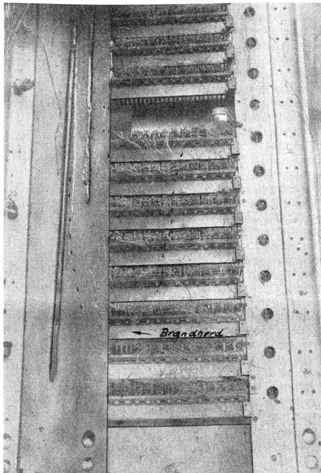
Fig. 9. Bucht, in der das Feuer ausbrach (die Kablierung ist entfernt worden).
