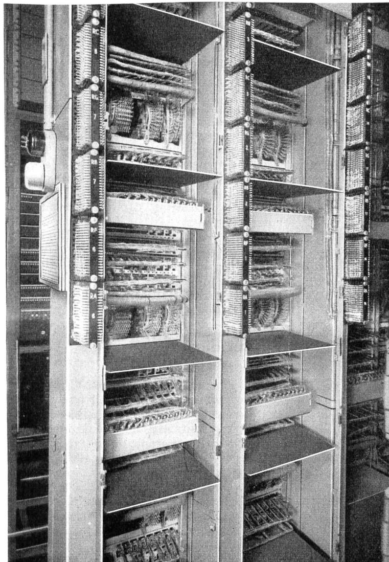
Fig. 12. Ansicht der Buchten mit horizontaler Abtrennung und weggenommenem Rückdeckel.
