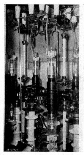
Fig. 5. Ansicht einer Zelle mit 4 Standard-Röhren zu je 100 kW. Die Stützen der Röhren sind aus Porzellan; sie werden ebenfalls für den Zu- und Abfluss des Wassers benützt. Die zwei Handräder dienen zum raschen Auswechseln der defekten Dreielektrodenröhren.
