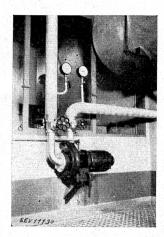
Fig. 3. Hänny-Pumpe zur Beförderung des Wassers der Zentralheizung.
