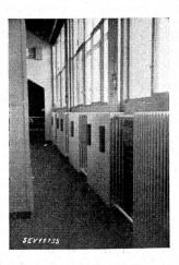
Fig. 4. Radiatoren Zehnder im Sende-Raum. Batterie de radiateurs Zehnder dans la salle d'émission.
