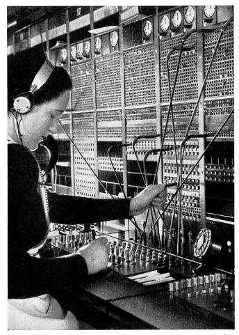
Abb. 3. Zentralbatteriezentrale, Vorläuferin der automatischen Anlage. Ausschnitt.
