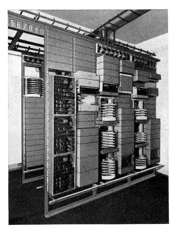
Abb. 19. Automatische Landzentrale System Hasler.
