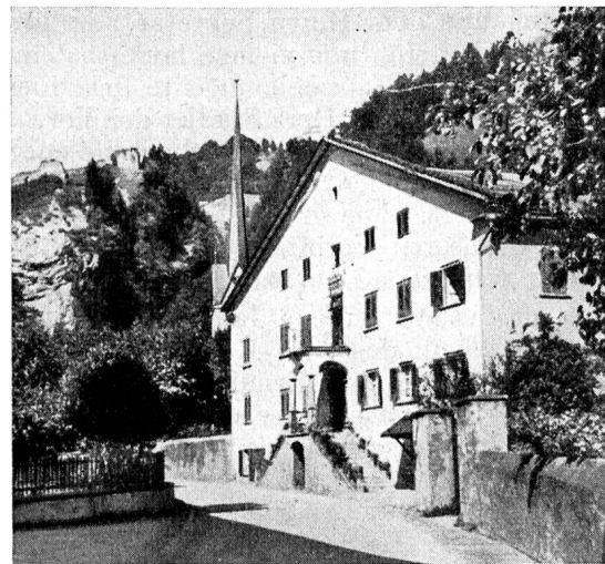
Abb. 20. Das vornehme „Heim“ einer Landzentrale.
