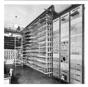
Abb. 12. Verteiler und Buchten für Hochfrequenz-Telephonrundspruch.
