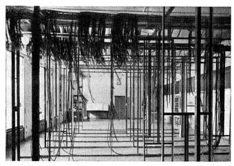
Abb. 14. Beginn der Montierungsarbeiten im Automatenraum.
