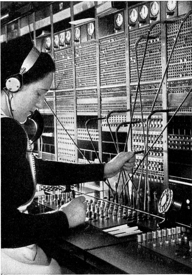
Abb. 3. Zentralbatteriezentrale, Vorläuferin der automatischen Anlage. Ausschnitt.
