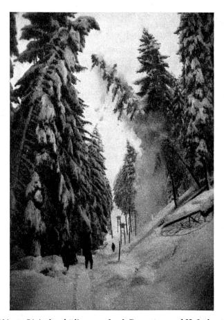
Abb. 5. Linienbeschädigungen durch Baumsturz und Naßschnee.
