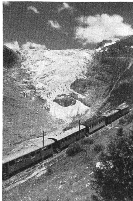
Abb. 1. Furkabahn mit Rhonegletscher. Phot. A. Klopfenstein, Adelboden. Nr. 1217 BRB 3. 10. 1939.
