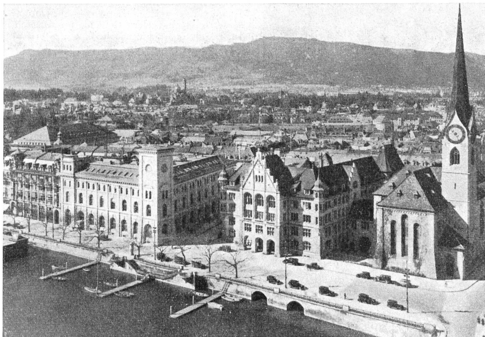
Abb. 10. Gleiche Reihe enthaltend Metropol-Post-Stadthaus-Fraumünster; Das Postgebäude von 1898, seit 1930 Fraumünsterpost. Aufnahme vom Karlsturm des Grossmünsters aus.
