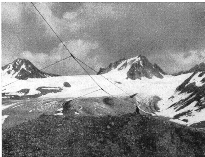
Abb. 4. An Felswand befestigte Queraufhängung der Leitung nach der Keschhütte.
