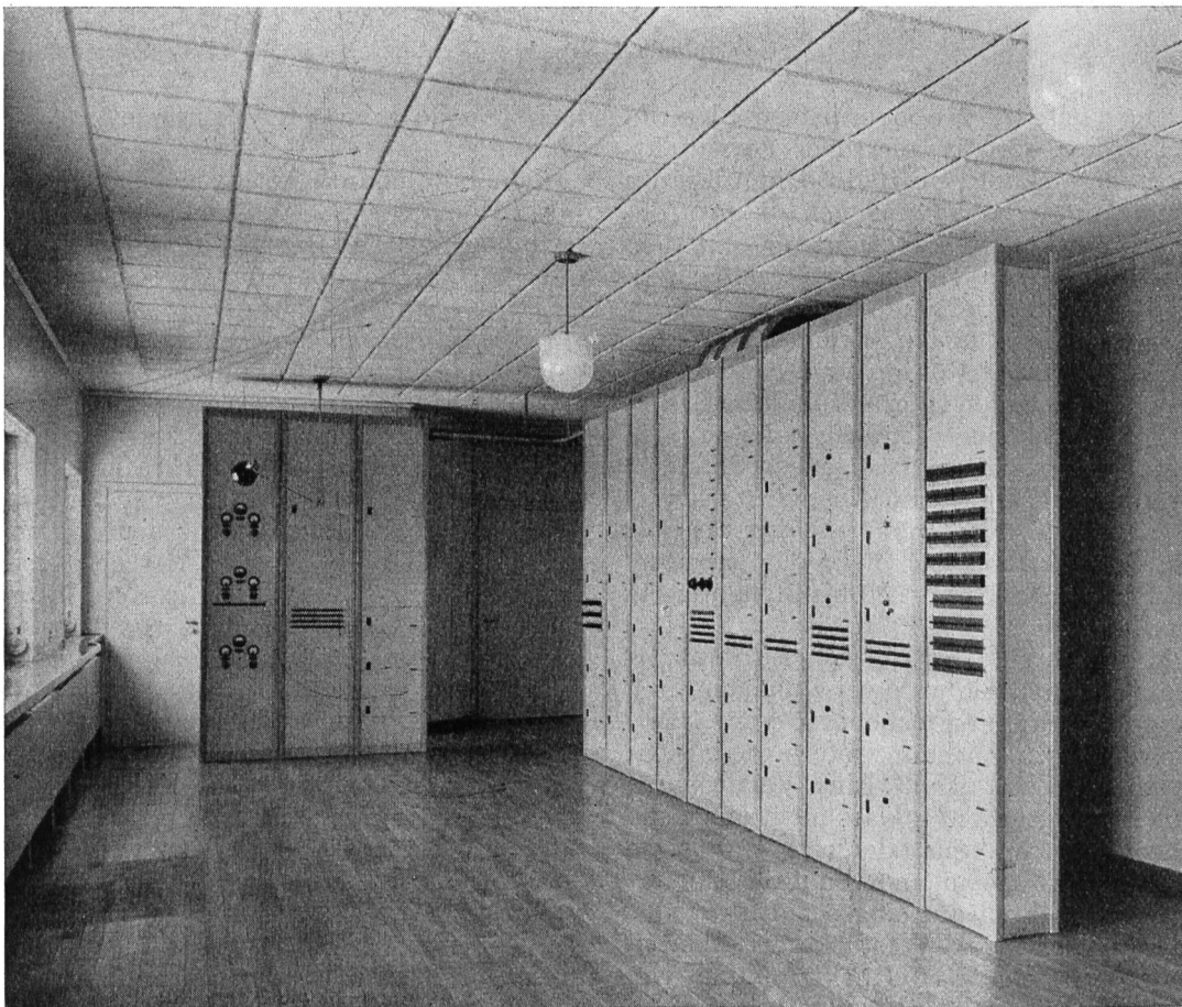
Fig. 5. Verstärkerbuchten. — Baies des amplificateurs.
