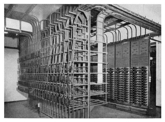
Abb. 31. Fernverteiler.
